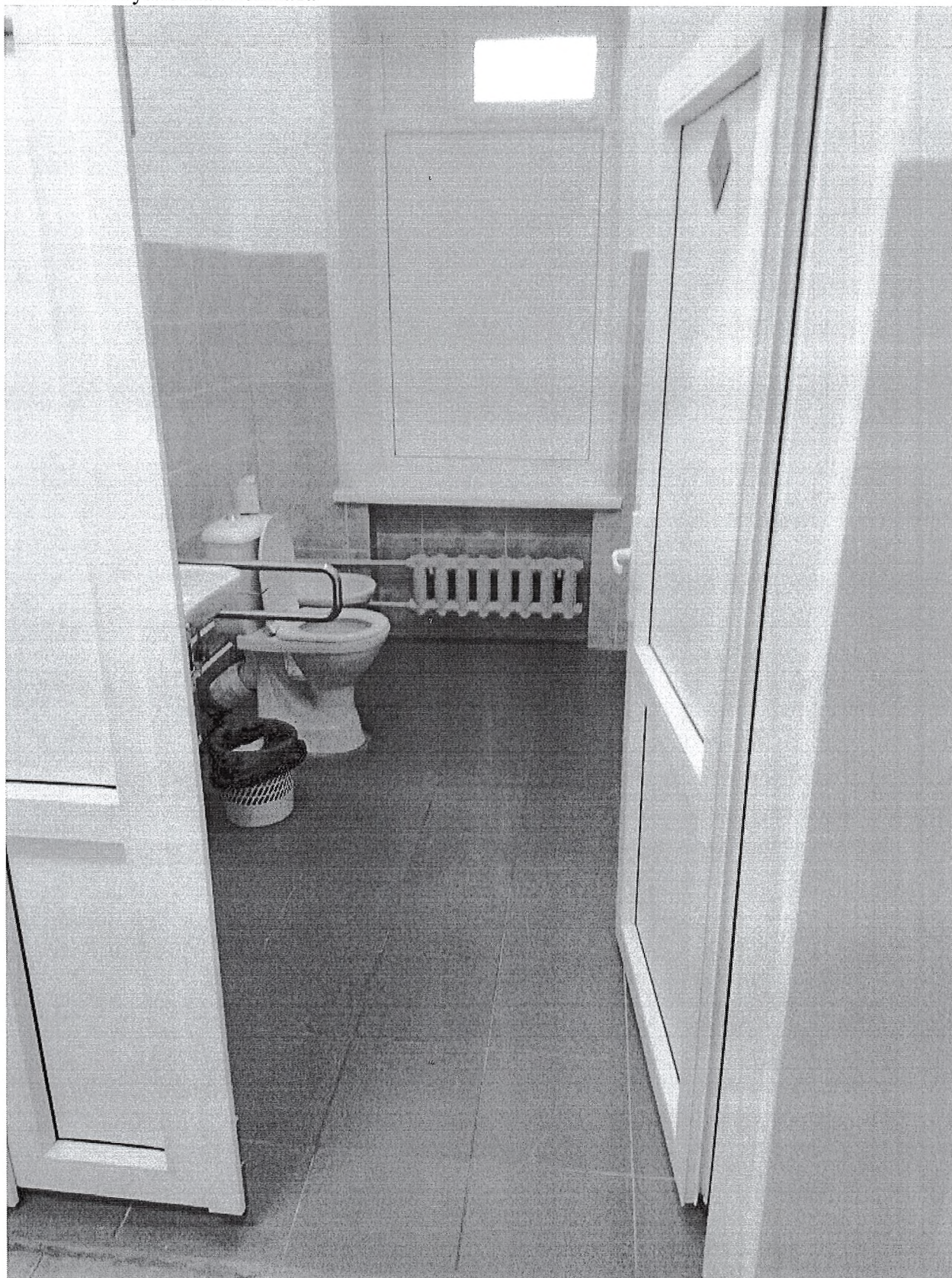
Фото №10 Туалетная комната
