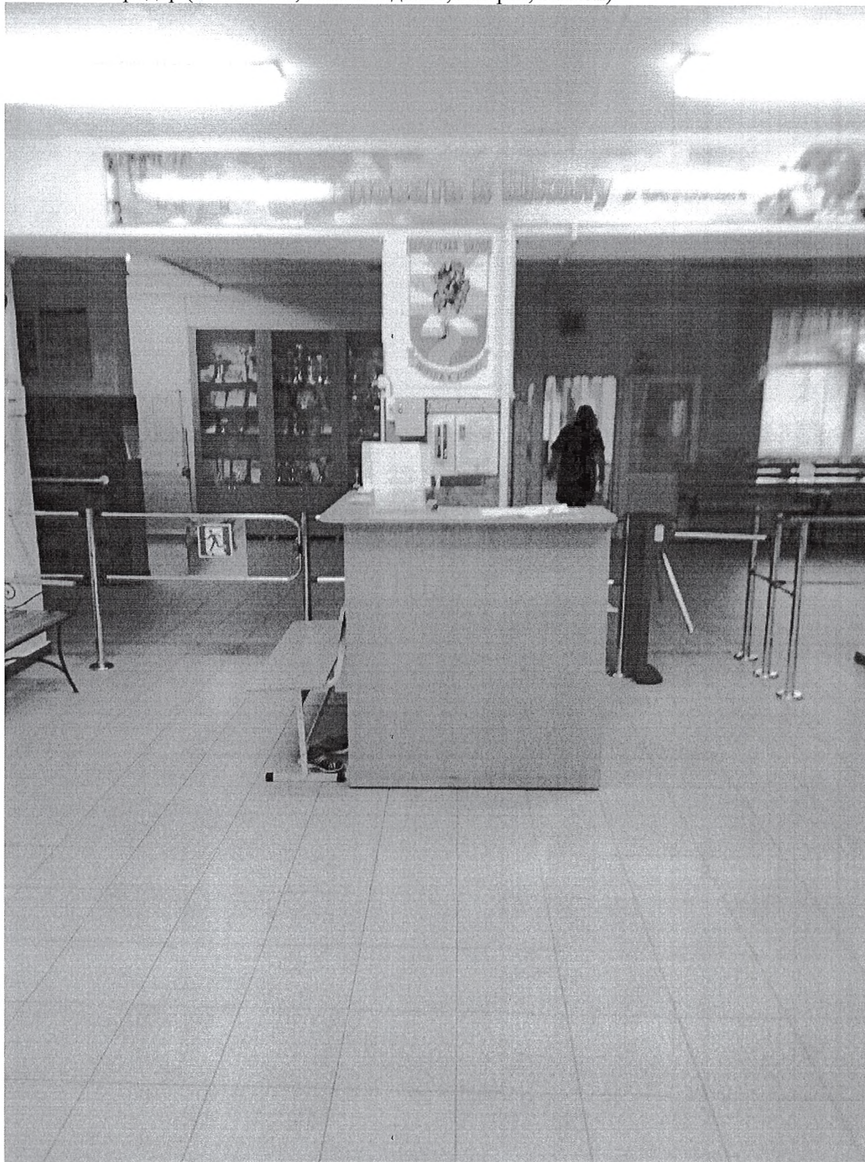
Фото №8 Коридор (вестибюль, зона ожидания, галерея, балкон)
