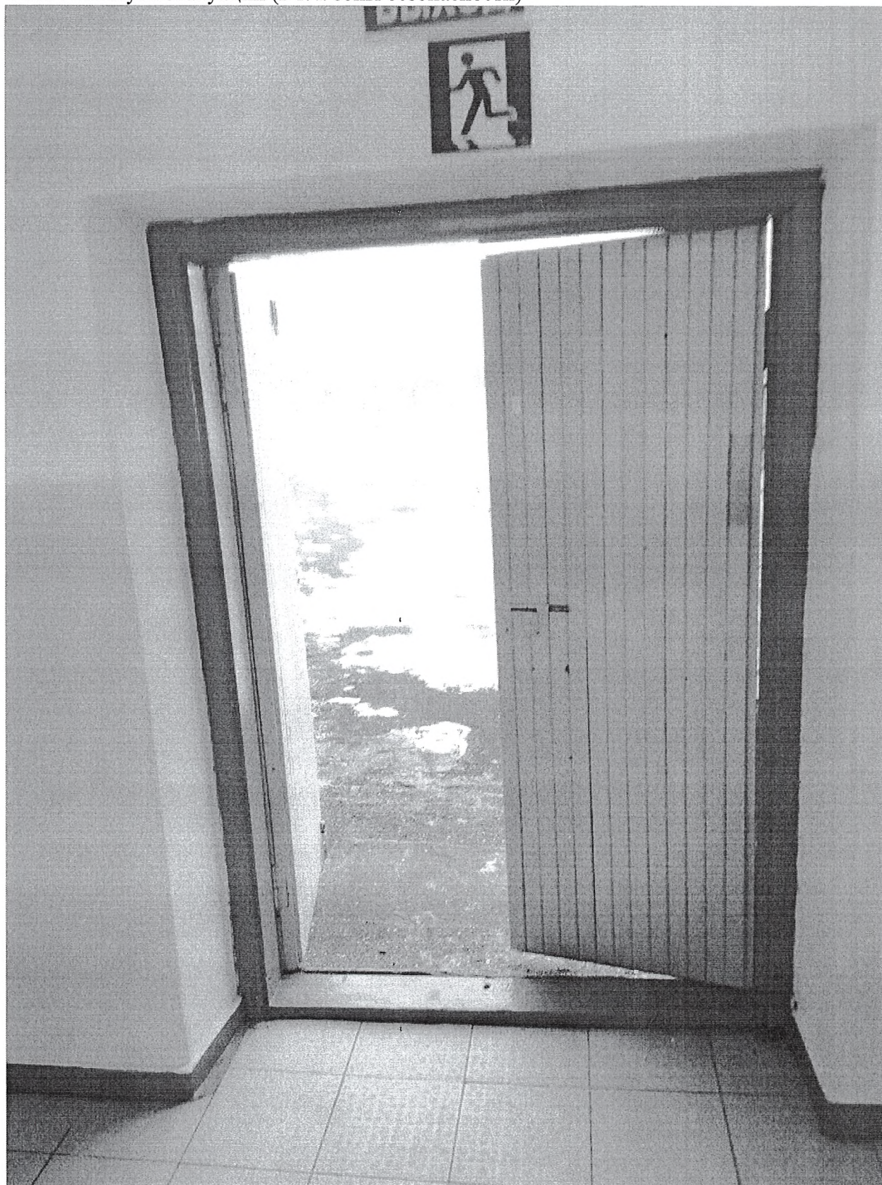
Фото №14 Пути эвакуации (в т.ч. зоны безопасности)
